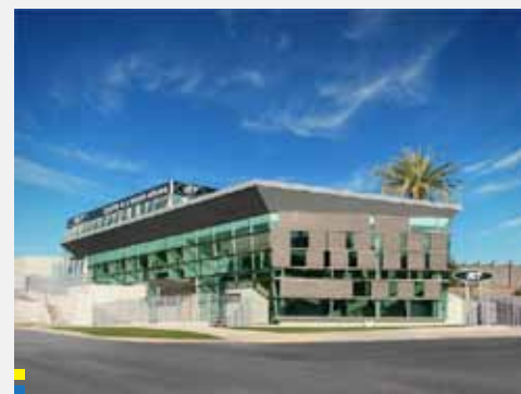
Las nuevas instalaciones del IST en Quilpué.
