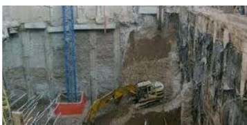
Figura 1: Despeje y excavación
