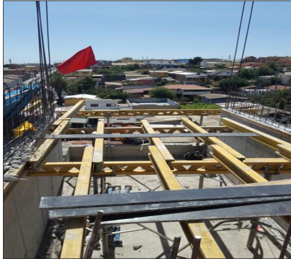
Imagen N°1: Instalación banderín rojo, fase crítica
