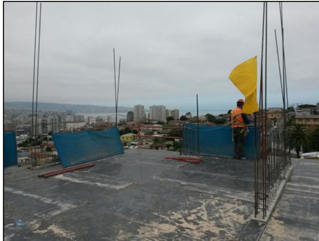
Imagen 2: Instalación de Banderín Amarillo y dispositivos de seguridad contra caídas
